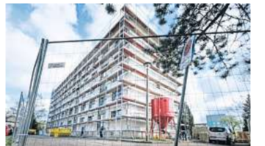
Blick auf das ehemalige Ledigenwohnheim. Der Umbau wird vorbereitet. FOTOS: WOLFGANG SENS
