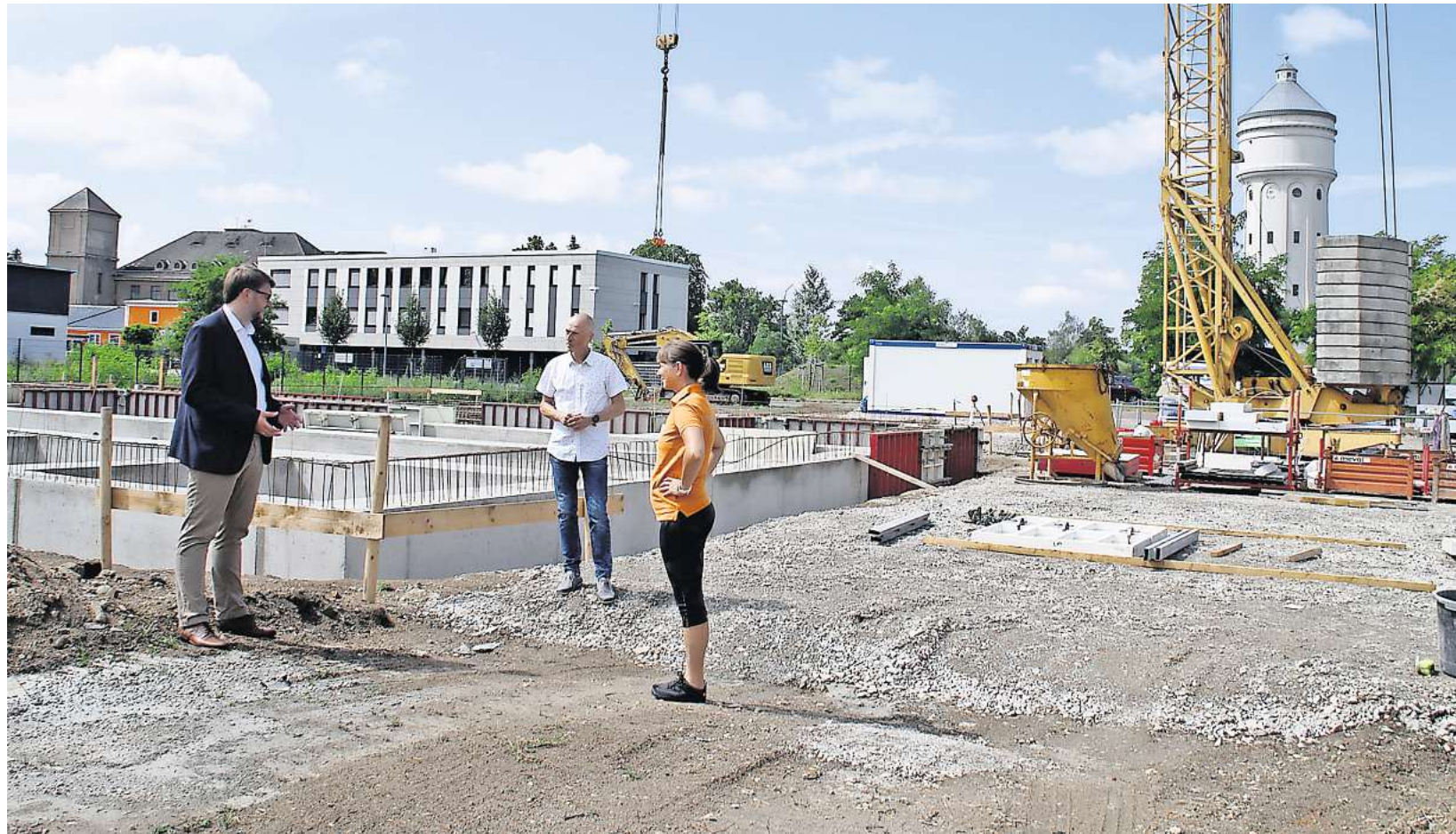
CDU-Bundestagsabgeordneter Marian Wendt (links) bei der Begehung der Baustelle für die Aktiv Oase mit Dirk und Petra Heynig.
